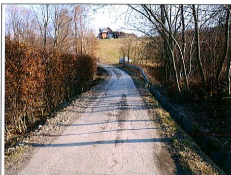
Odcinek drogi ponad osuwiskiem (L)
